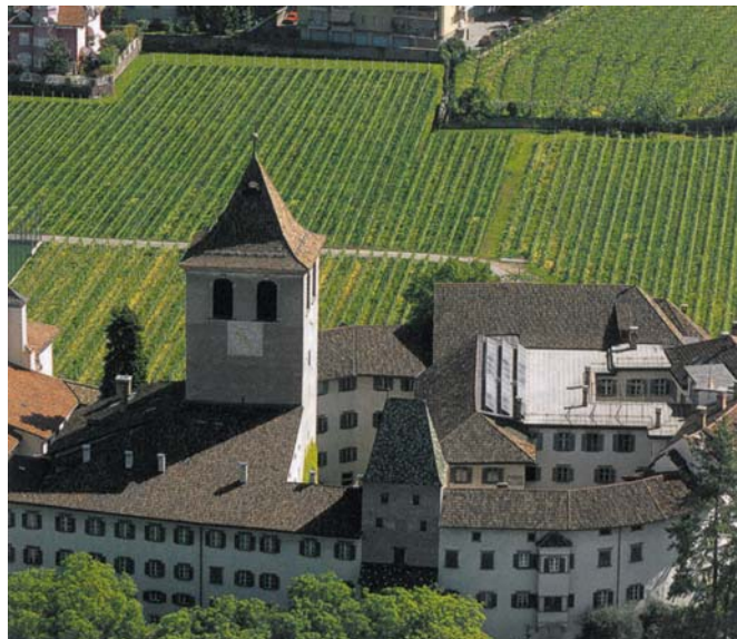
Foto Abtei Muri-Gries
